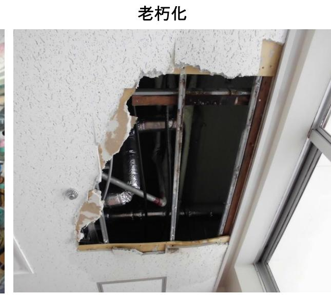
配管からの漏水で天井材が落下
